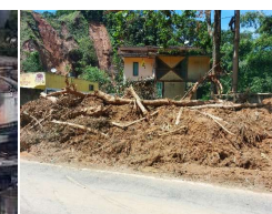
Deslizamento São Sebastião 2023. Foto: CV
