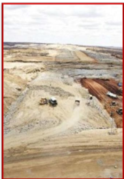
Obras de Construção da Barragem Figueiredo
